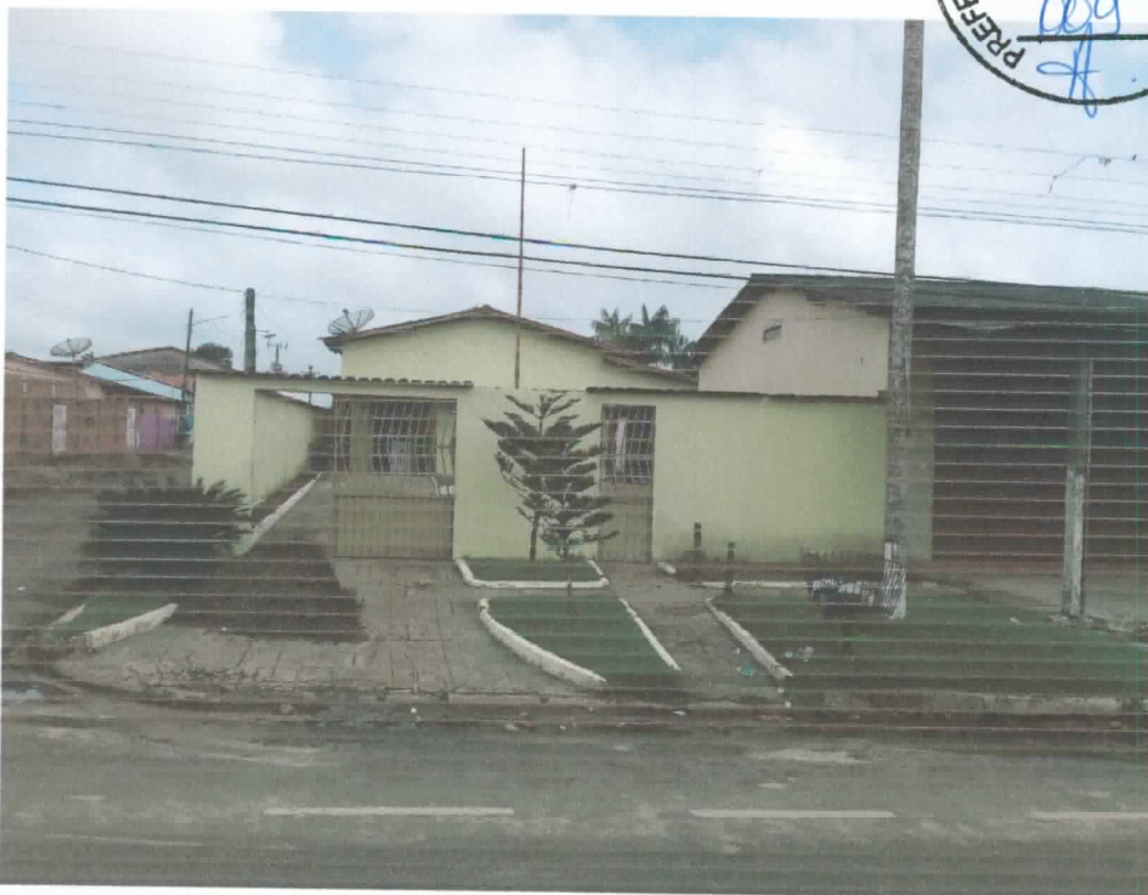
Figura 01: Vista frontal da Edificação – fachada principal.
